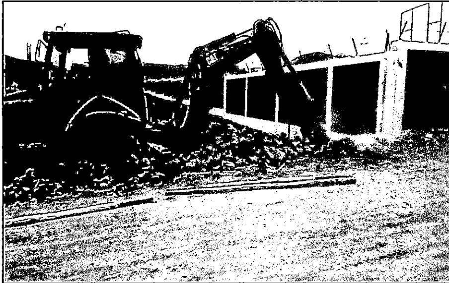
VISTA 03. INICIO DE LAS EXCAVACIONES DEL CERCO CON MAQUINARIA PESADA.
