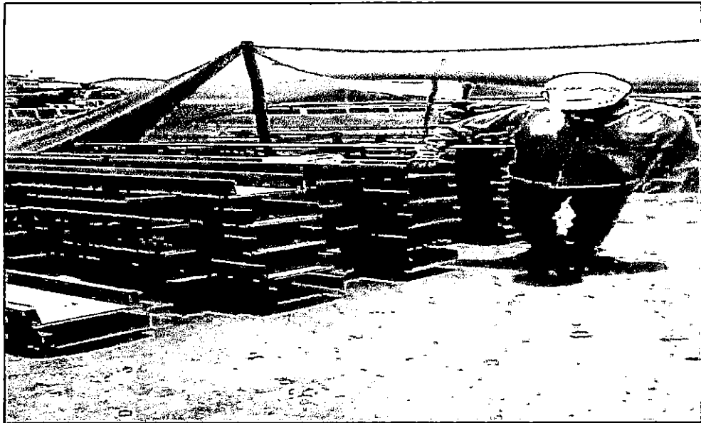
VISTA 10. VERIFICACION DEL ENCOFRADO DE COLUMNAS POR PARTE DEL SUPERVISOR.
